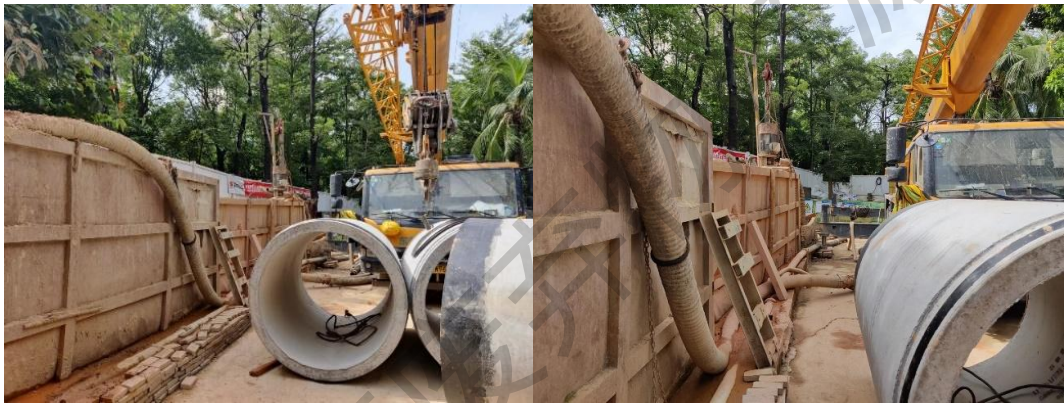
图 28 顶管施工现场
