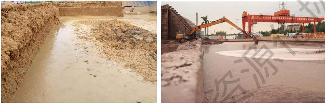
图 25 土压平衡盾构泥浆
